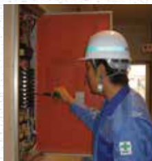
配電盤の点検の様子
