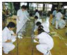
鉄筋を組み上げる生徒たち
