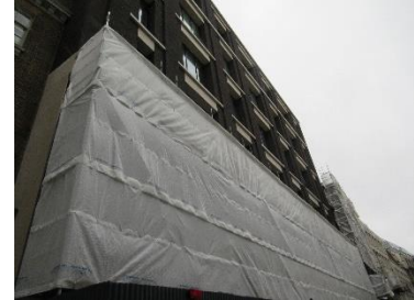
工事現場外観
