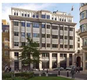
元々のビル（55 Moorgate）
