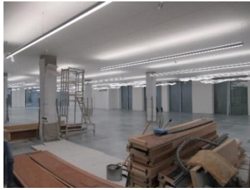
エレベータシャフトがあった フロア中央部
