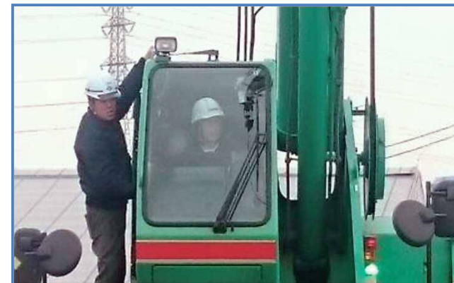
【クレーン実習風景】
